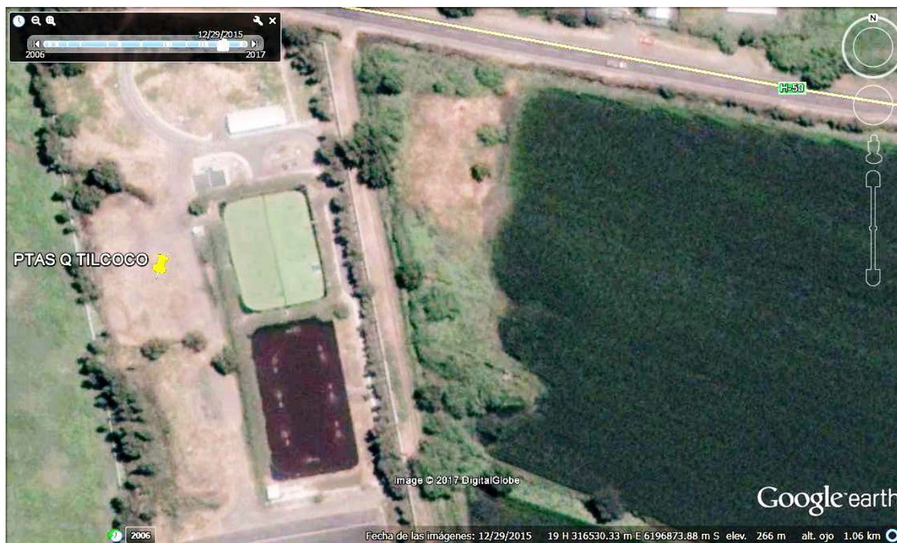
Figura 6. Planta Elevadora y de Tratamiento de Aguas Servidas.
